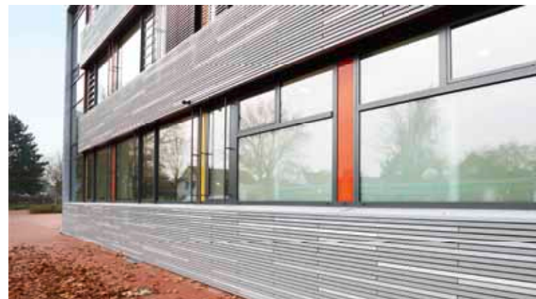
Mehr Raum, weniger CO 2 -Emissionen: Nach 34 Jahren war die Anne-Frank-Schule in Gütersloh nicht nur zu klein, sondern auch energetisch sanierungsbedürftig.
