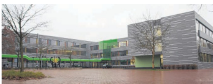
Rechts mit dreigeschossigem Klassen- und Verwaltungstrakt: Der Anbau ist schon seit geraumer Zeit fertig.
