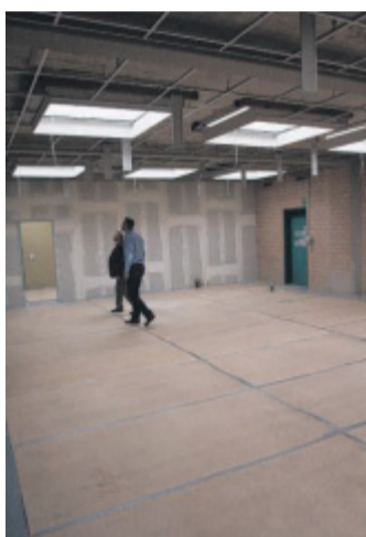
Wird ein Chemieraum: Eine der aktuellen Baustellen.
