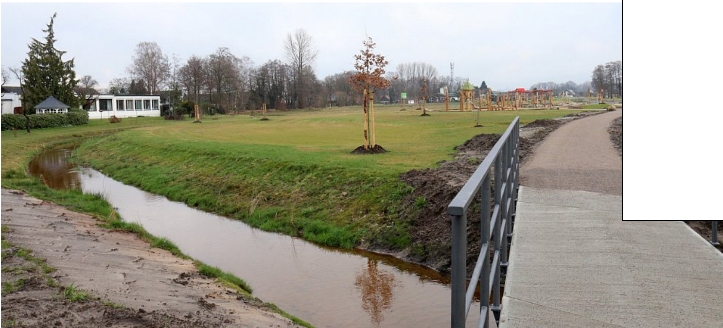
FERTIG: DER SPIELPLATZ, DIE GEWÄSSERUMFLUT UND DER RADWEG DURCH DIE KRULLSBACHAU SIND BEREITS ANGELEGT. | © ROBERT BECKER
